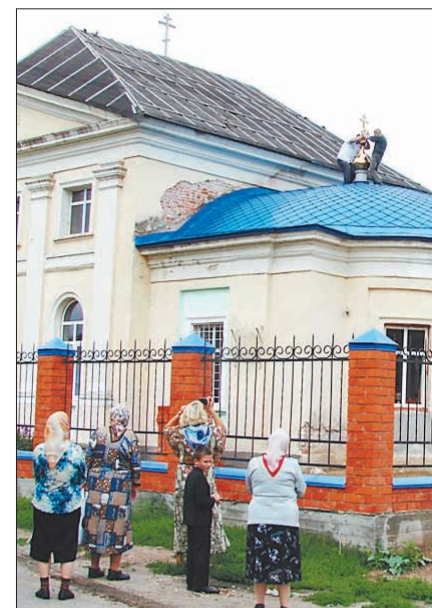
Установка креста над алтарной частью.
